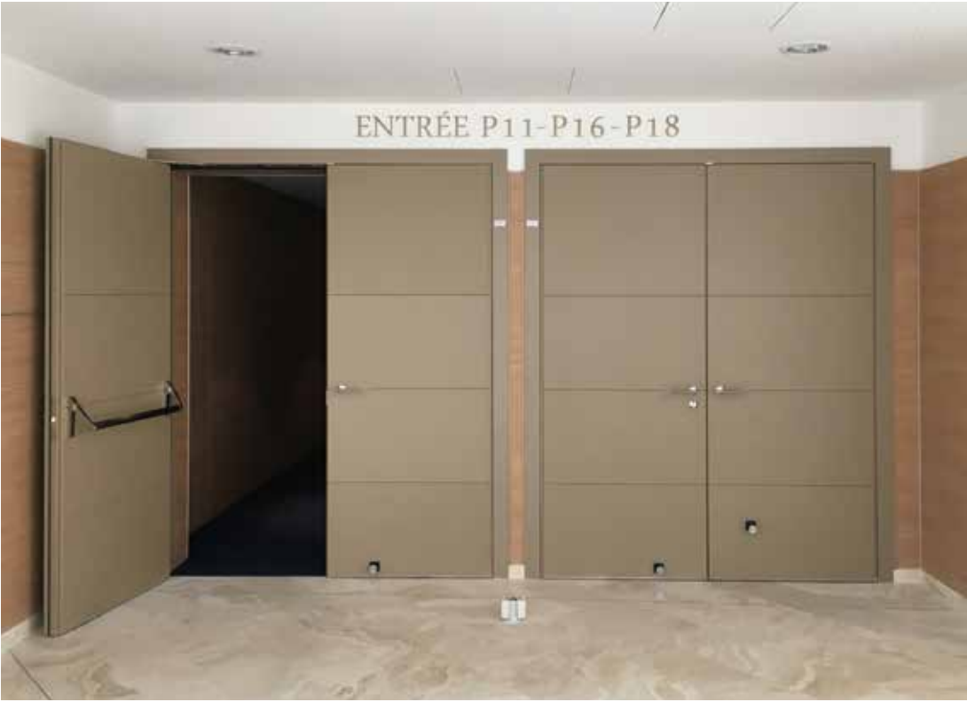
Per la principale sala congressi Barausse ha fornito porte doppie laccate e pantografate certificate per la resistenza al fuoco e fonoisolamento, secondo le normative UNI EN.
